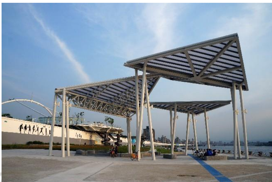
圖 2-10 延平河濱公園自行車道紙飛機造型休憩區
